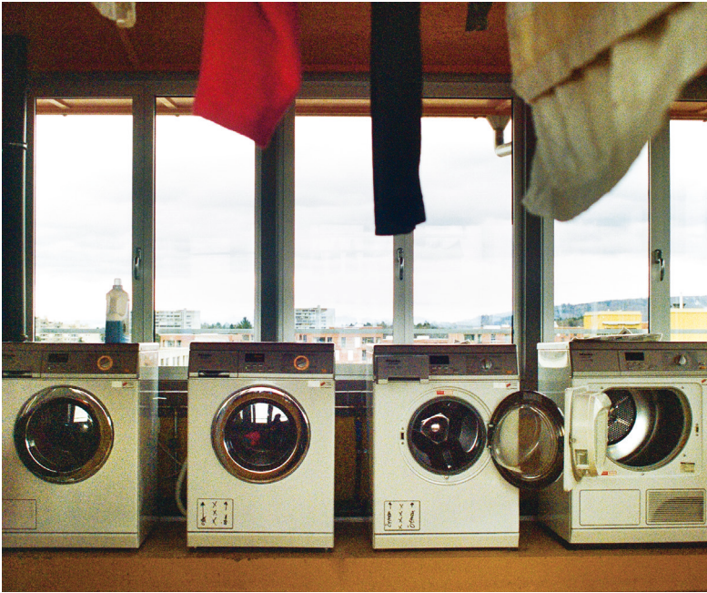
1.11 Laundry room at the Gemeinnützige Mieter- und Baugenossenschaft Zürich, Siedlung Klee, 2020
