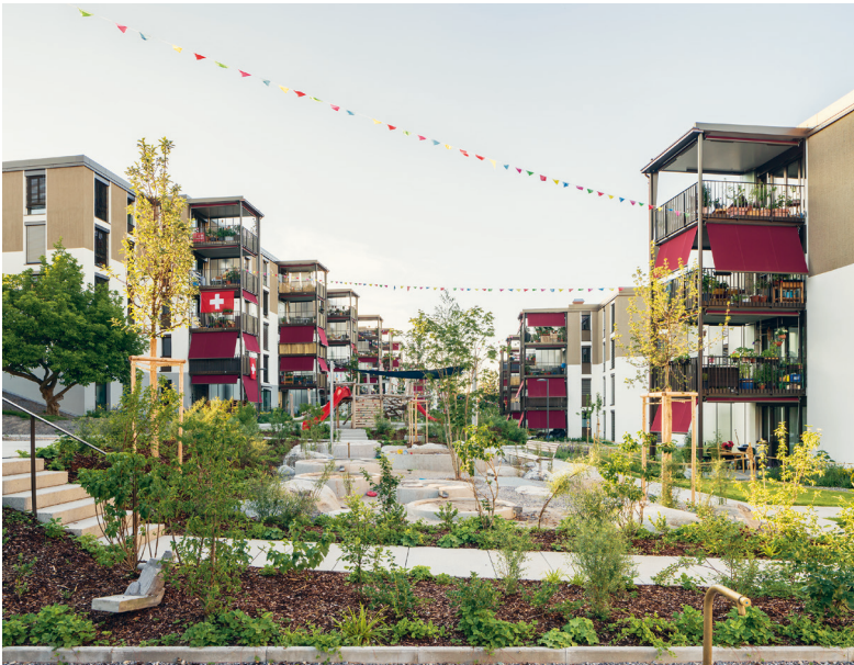
7.8 Shared central courtyard of the Ersatzneubau , Entlisberg, 2018
